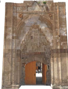
Karatay Kervansarayı taç kapısı
