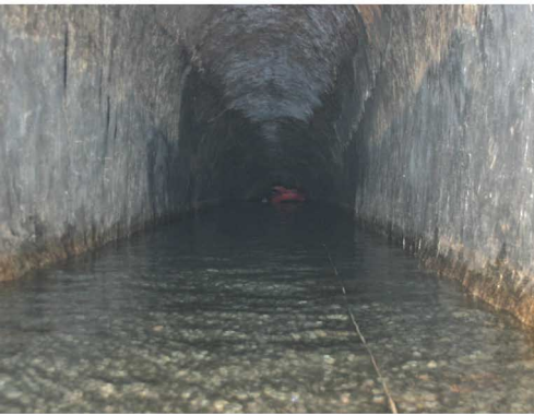
Talas yeraltı şehrinde yer alan sarnıç
